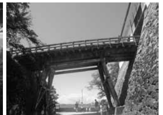
図2 天秤槽と廊下橋
